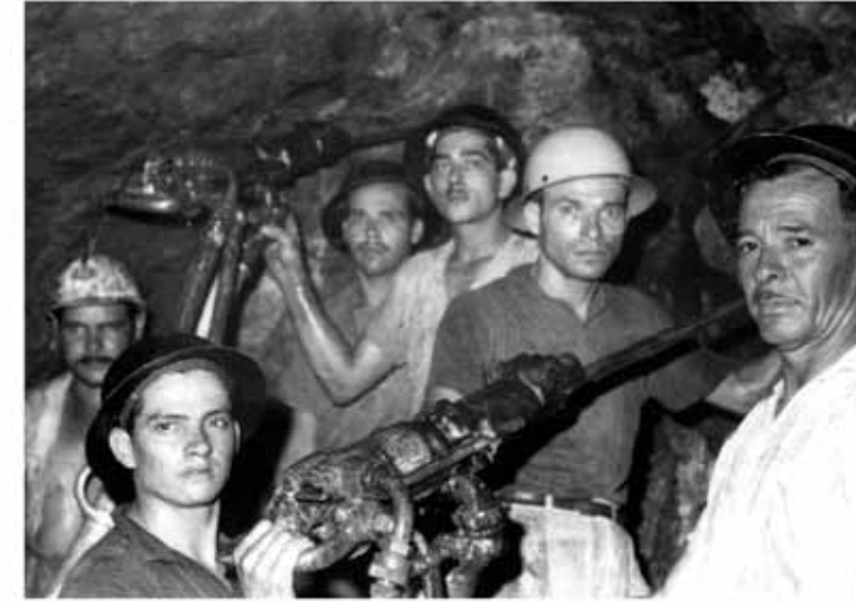
Un grupo de tuneleros, como soldados de las profundidades, posa con sus perforadoras durante la construcción del Proyecto Hidroeléctrico Cachí. (1962-1966)
