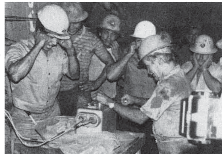
Un tunelero hace girar el manubrio del generador eléctrico y desde lo profundo de la tierra, se escucha el tronar de dos o tres retumbos. Su vibración sacude nuestras ropas. El tope ha volado en pedazos. (Proyecto Arenal).
