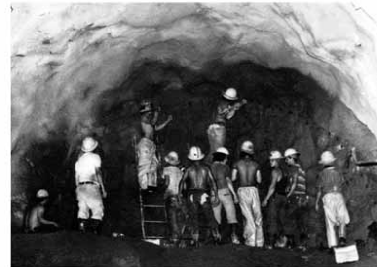
Los agujeros abiertos en el tope son ahora cargados con explosivos. Los atacadores, especie de varillas de madera, permiten alojar debidamente los cartuchos entre la roca.
