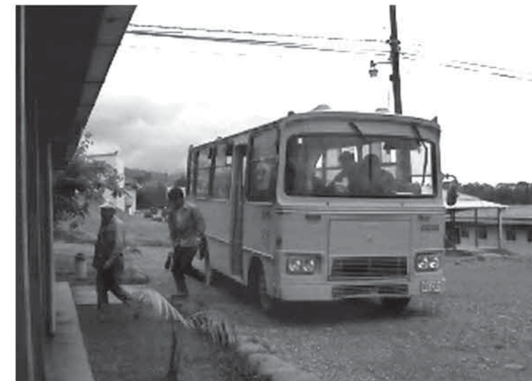
¡Llegamos! Una cuadrilla de tuneleros procedente de su frente de trabajo viene arribando al plantel. Ha terminado la jornada laboral y se inicia el descanso. (Proyecto Toro.)
