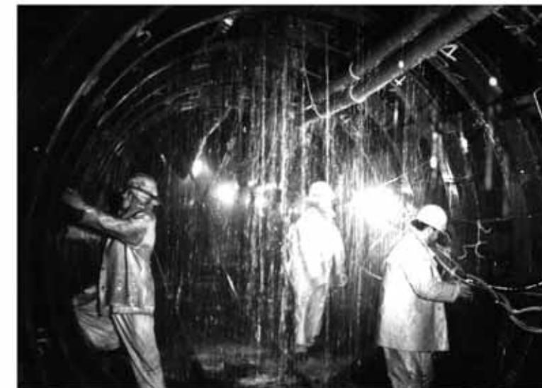
Recordando Tapantí. Bajo una fría lluvia subterránea, un grupo de tuneleros realizaba su labor en Tapantí. Aparentemente remueven el tendido eléctrico para iniciar el revestimiento de concreto.
