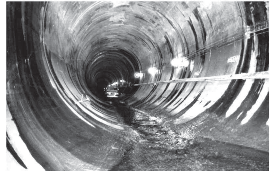
Por fin son desmontados las formaletas, y un gigantesco túnel de concreto de 7.5 metros de diámetro por varios kilómetros de largo queda al descubierto. Aquí se observa un vehículo en labores de inspección, en un túnel de desvío del Proyecto Hidroeléctrico Arenal.
