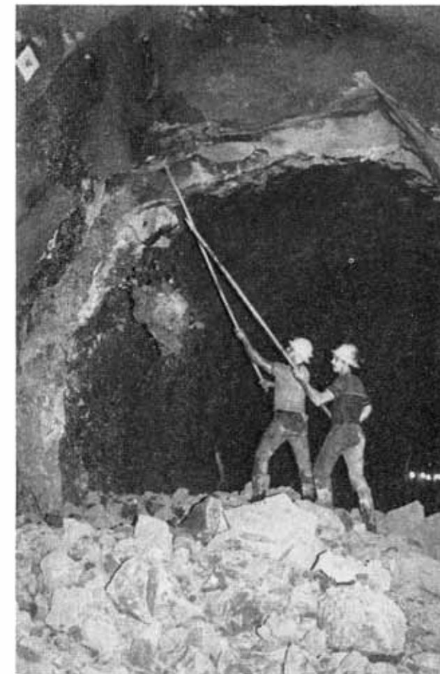
Han volado el último tope. Donde estuvo la pared de piedra solo queda ahora un montón de escombros. Dos tuneleros ejecutan la riesgosa tarea de aflojar el material inestable que cae estrepitosamente.
